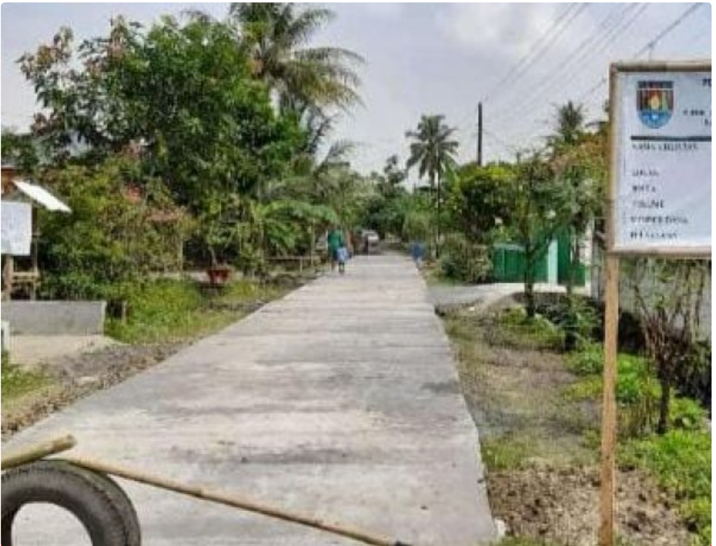
Warga Merasa Senang Pembangunan Jalan di Dusun Karangreja
